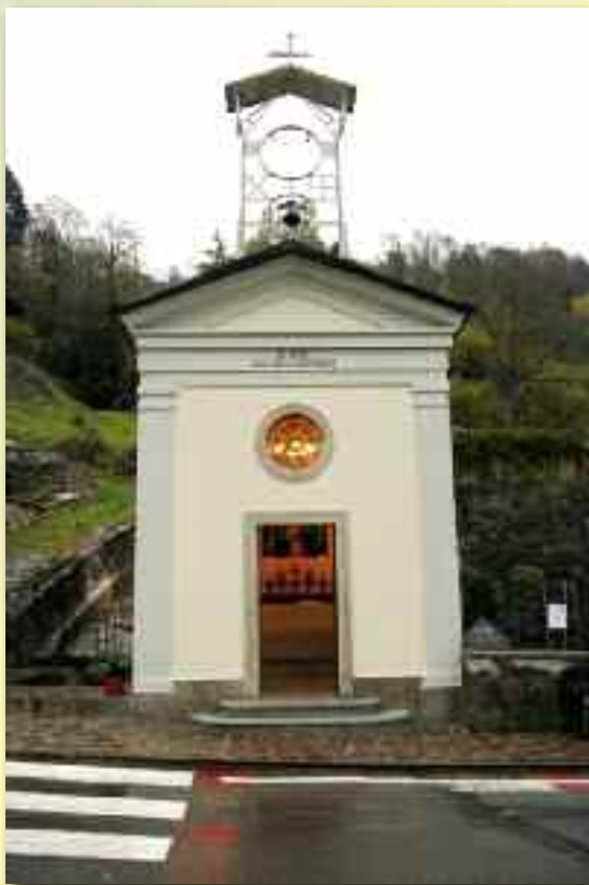
Chiesetta di S. Carlo restaurata
