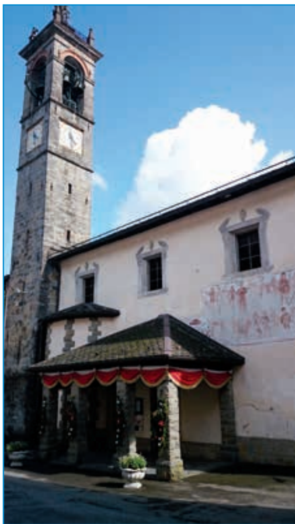
Campanile della chiesa di Cassiglio
